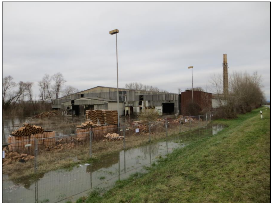
Das brachliegende Betriebsgelände Herrenteich beim Hochwasser am 24.01.2018, als der Wasserstand des Rheins seinen Höchststand erreicht hatte (Pegel Speyer: 8,14 m). Weite Bereiche des Geländes sind überflutet. Foto: Uwe Heidenreich (BUND)
