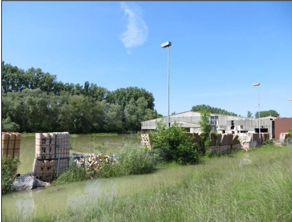
Überflutung des Plangebiets am 04.06.2013
